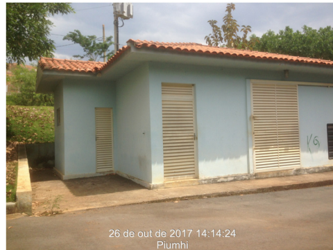
Foto / Ampliação de Cobertura
