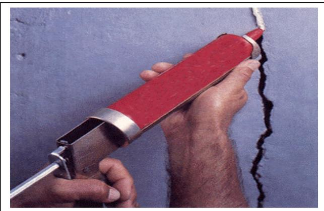
**Fig. 09.** Preenchimento da trinca
