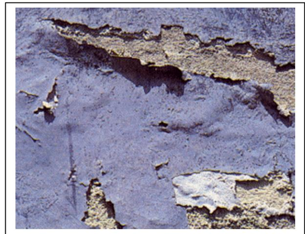
**Fig. 03.** *Desagregamento*
