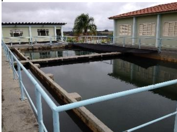
Foto 6. Decantadores 1 e 2 – ETA de Piumhi
