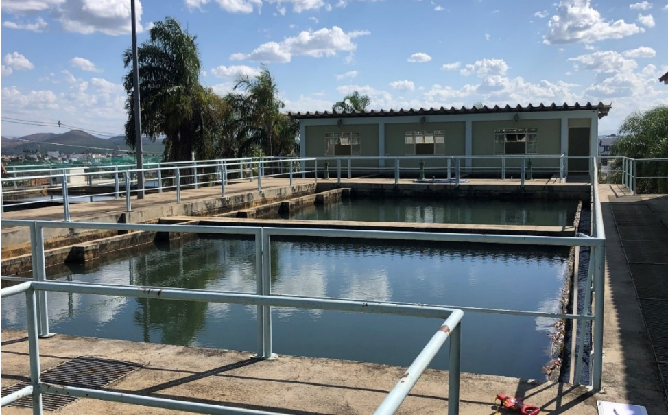
Foto 13: Decantadores 01 e 02 da ETA
