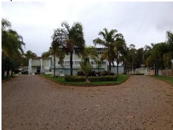
Foto 1. Entrada principal ETA de Piumhi.
