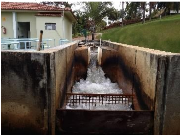
Foto 4. Vista de vertedor Parshall da ETA de Piumhi.
