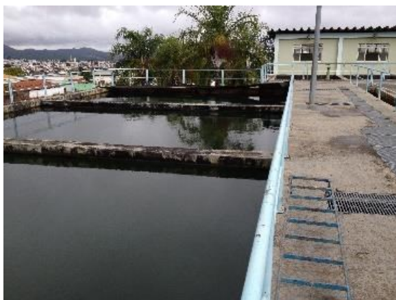
Foto 7. Decantador 3 – ETA de Piumhi.
