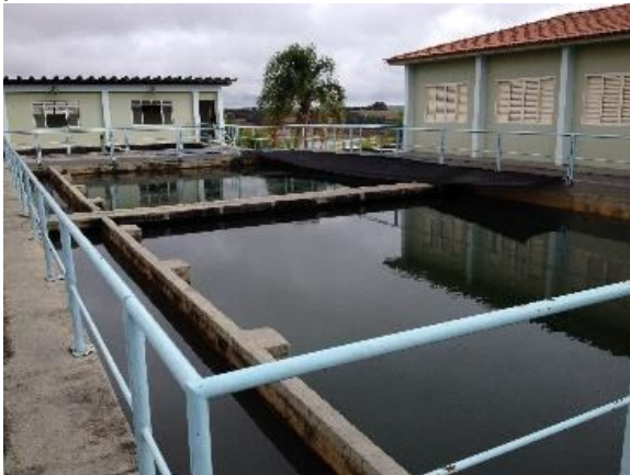
Foto 6. Decantadores 1 e 2 – ETA de Piumhi
