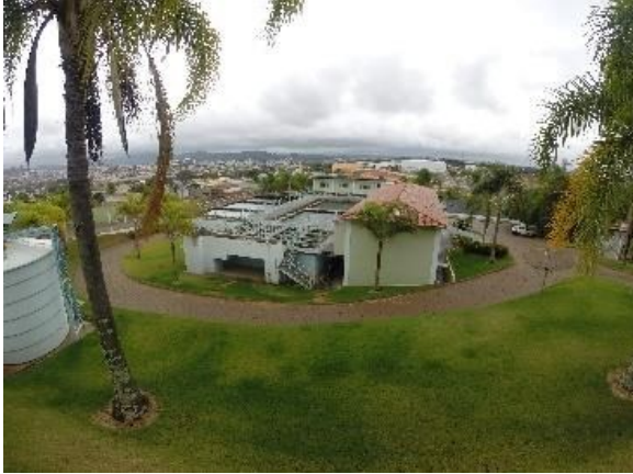
Foto 3. Vista geral das unidades de tratamento ETA Piumhi.
