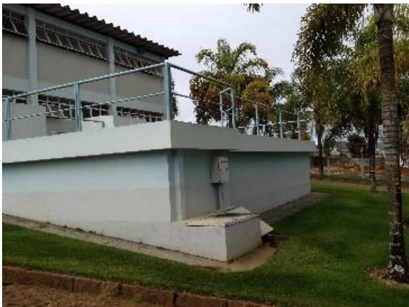
Foto 9. Vista do tanque de contato da ETA de Piumhi.
