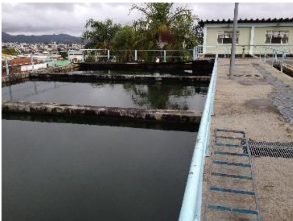
Foto 7. Decantador 3 – ETA de Piumhi.
